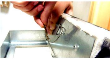
4. FINISH BY HOOKING THE OTHER END OF THE FUSIBLE LINK THE TO STRAIGHT CLIP FROM THE OPPOSITE BLADE.
